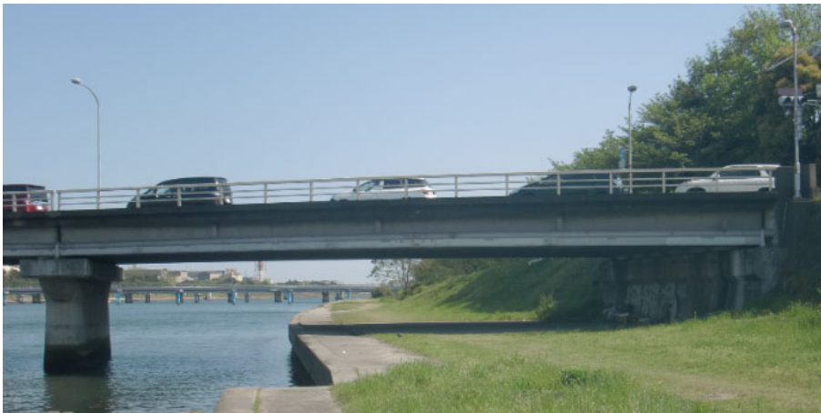
図 3.75 対象橋梁全景
