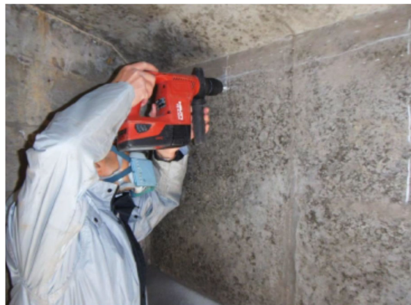
図 3.87 アンカ削孔状況
