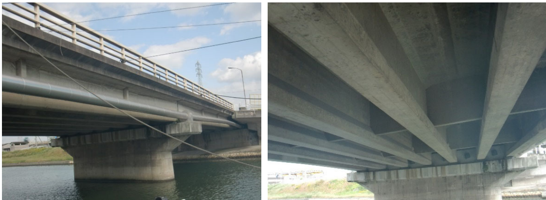
図 2.1 河川堤防から遠望目視点検により撮影した事例
