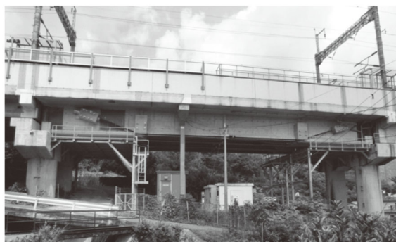
a) 外ケーブル設置状況
