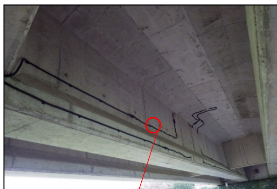
図 3.49 支間中央部のセンサ設置状況
