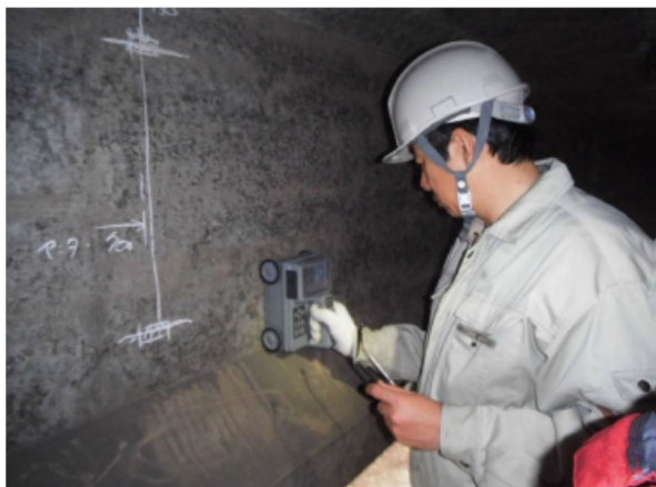
図 3.86 鉄筋探査状況
