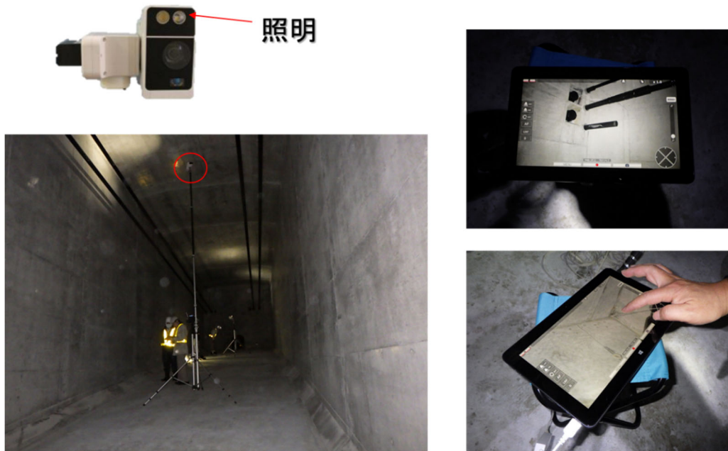
図 2.19 暗所（箱桁内）での点検状況
