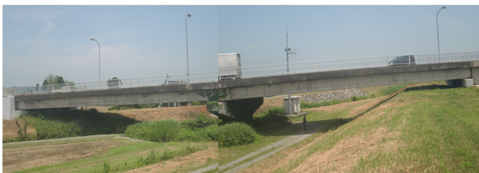
図 3.41 M橋の全景
