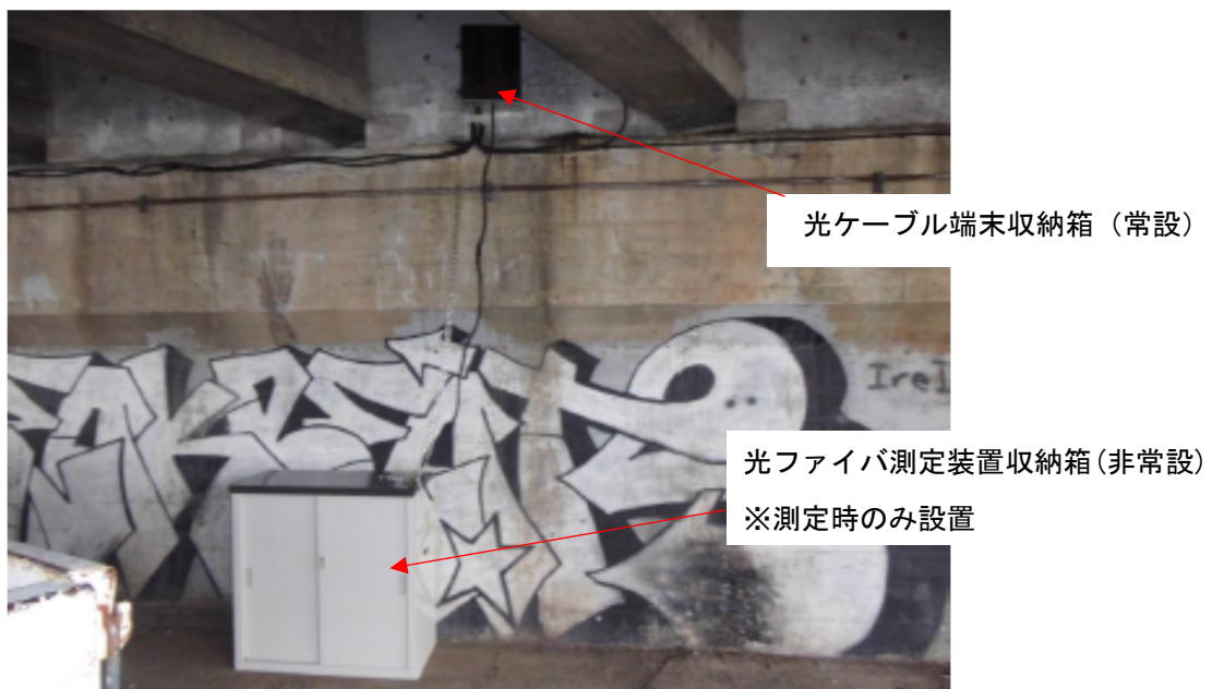
図 3.91 光ケーブル端部の収納
