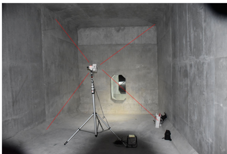
図 2.36 ロボットカメラ点検の状況
