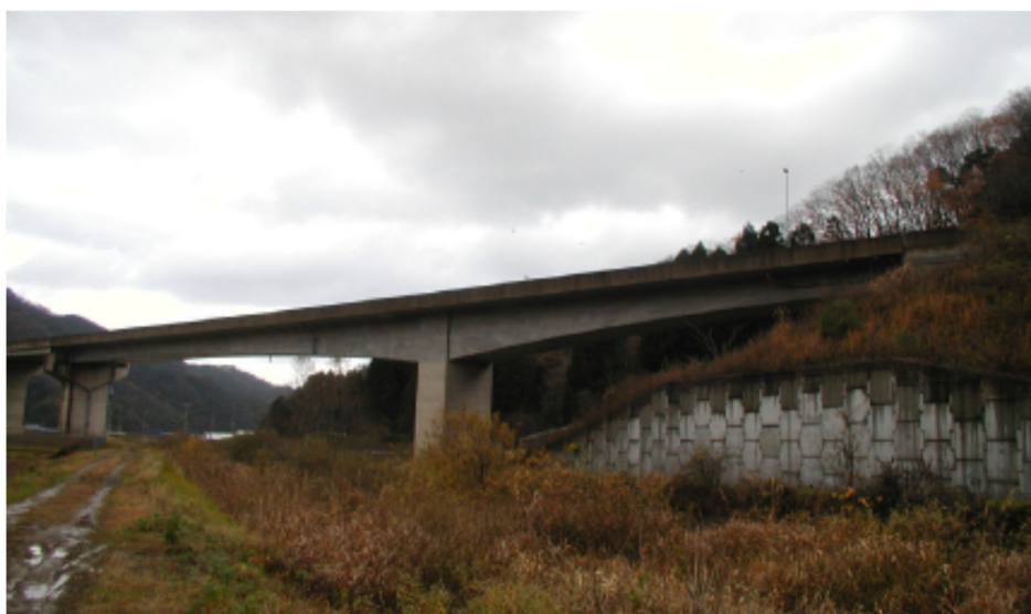
図 2.33 対象橋梁の全景
