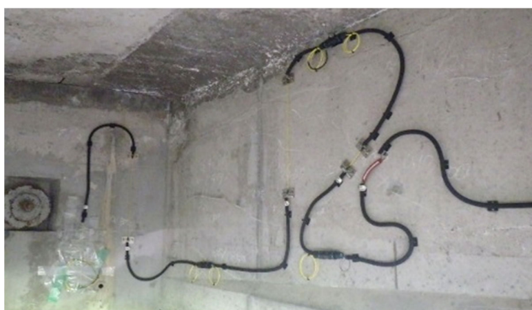
図 3.48 主桁端部のセンサ設置状況
