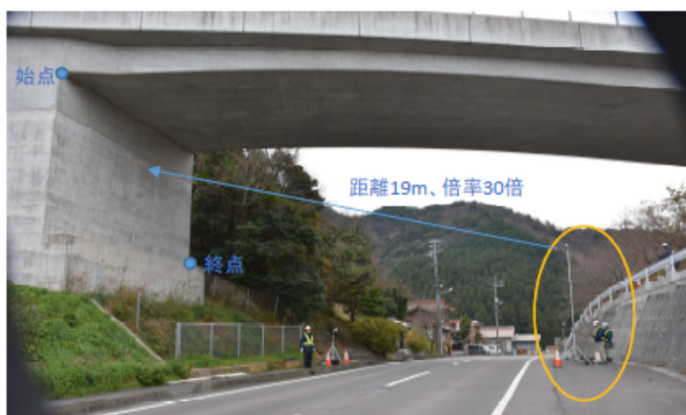
図 2.26 連続自動撮影機能を用いた点検状況
