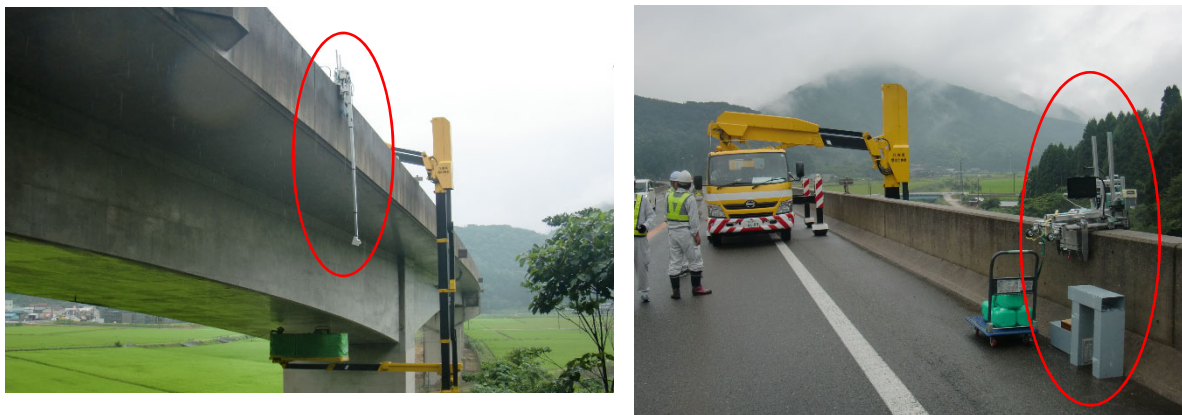
図 2.42 橋梁点検車による近接目視点検と自走式ユニットによる無人点検状況
