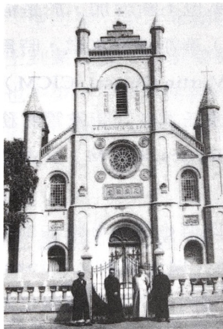
写真 6: 徳玉明によって建てられた西営子教堂(南壕塹) (1872-1874 年) 363
