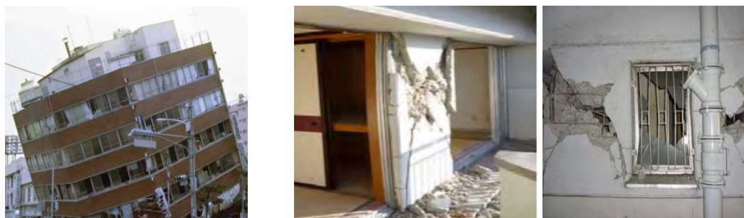
(a) 兵庫県南部地震で倒壊した建物
