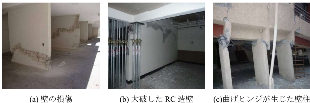
図－1.2 2010 年チリ地震で破壊された RC 造壁部材 1.7)~1.8)
