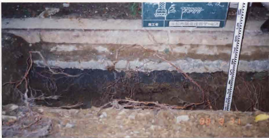
写真5-8 ソメイヨシノの掘削状況
