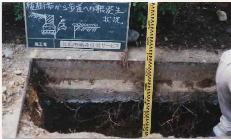
写真5-7 ソメイヨシノの掘削状況
