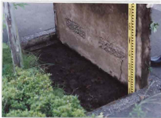
写真5-9 ヤマザクラの掘削状況
