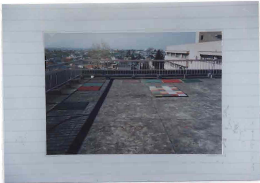
写真 4 - 1 屋上の試験状況（未歩行部）
