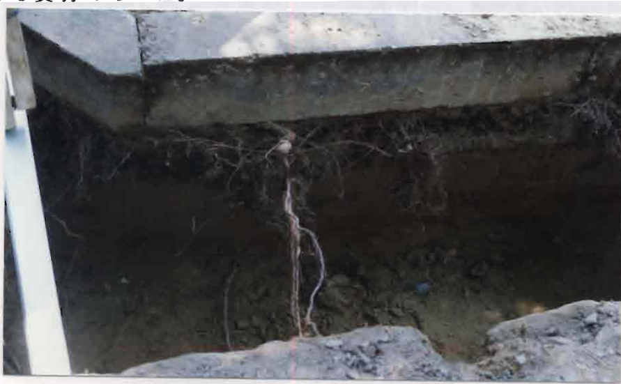
写真5-4 ケヤキの掘削状況
