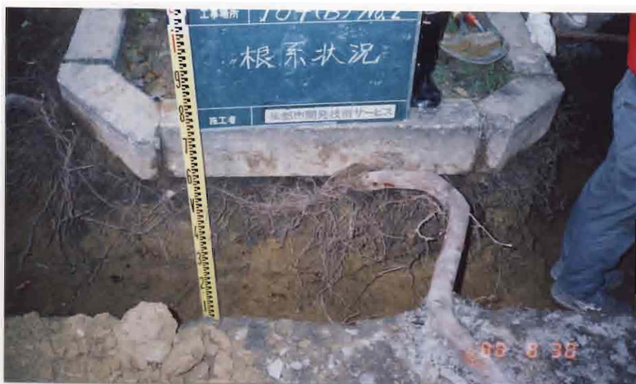
写真5-6 ケヤキの掘削状況
