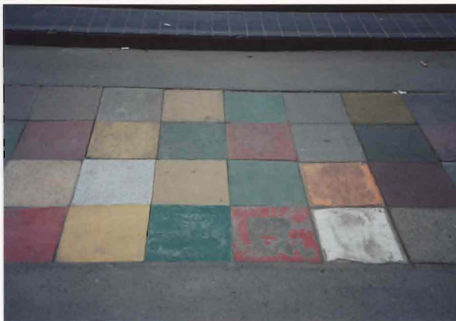
写真 4 - 3 建物前の塗装の変化（約 1 年後の状況）
