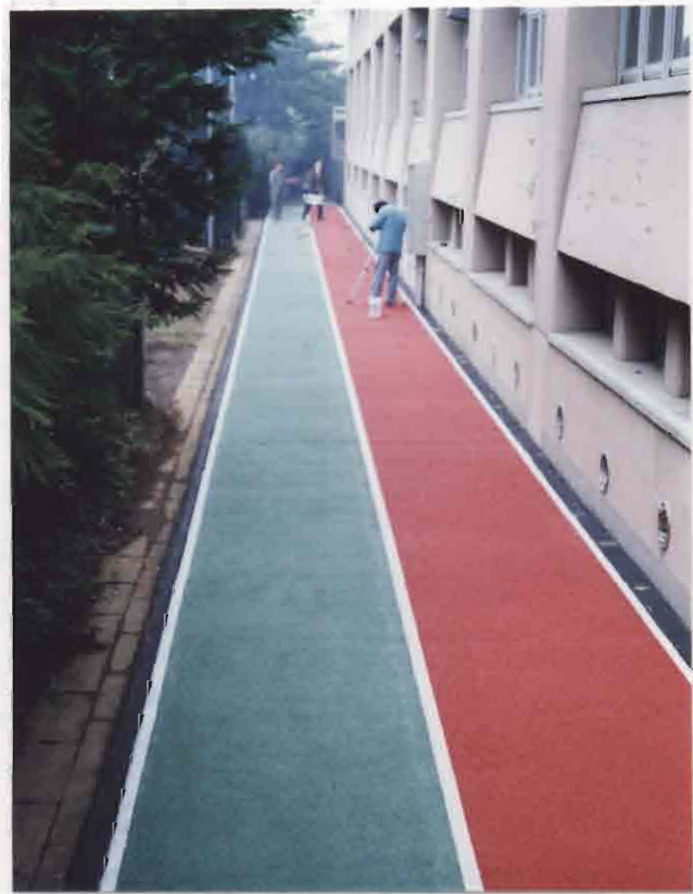
写真 3 - 1 歩経路の状況
