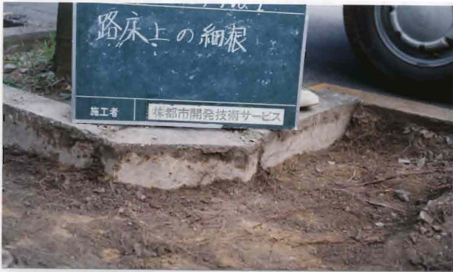
写真5-5 ケヤキの掘削状況
