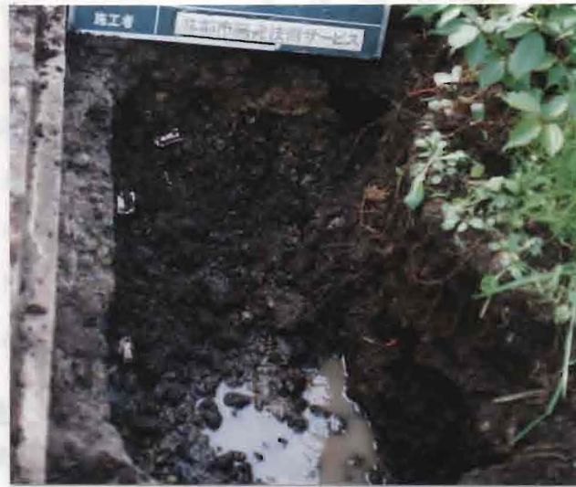
写真 5 - 1 0 ヤマザクラの掘削状況
