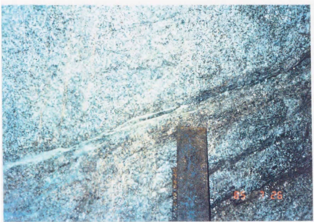
写真 4.1 当地域の下水道トンネル工事 掘削断面における花崗岩の露出状況
