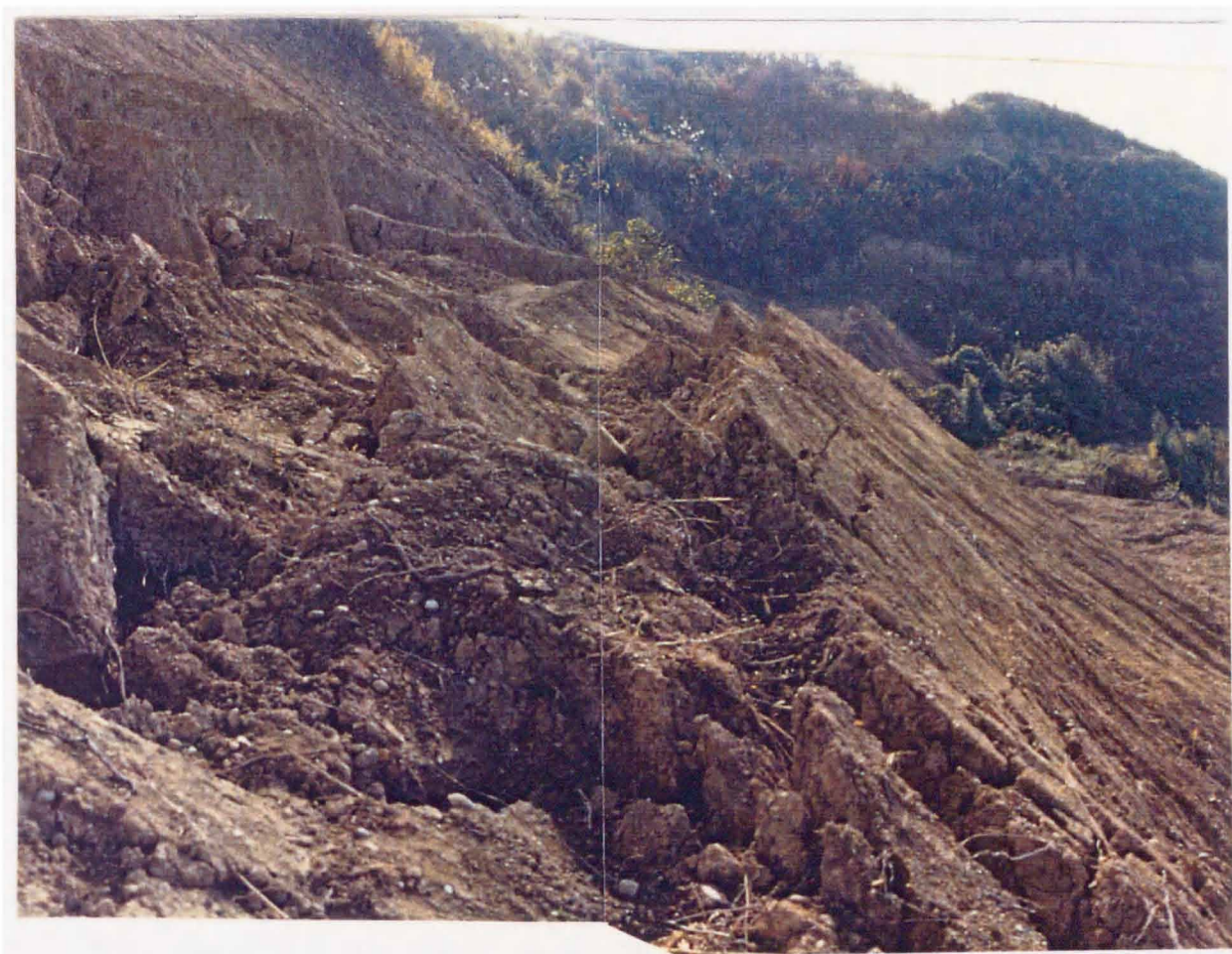
写真-2.4 崩壊した試験斜面の滑落崖
