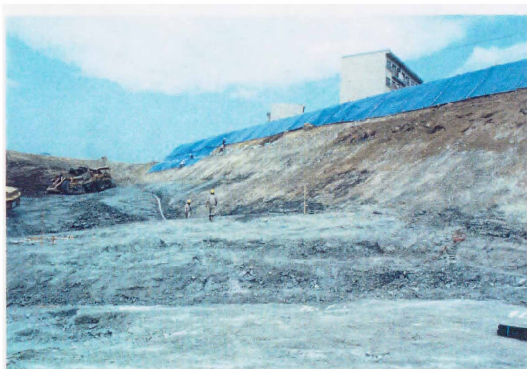
写真-4.4 置換工の掘削完了状況(下面是泥岩層)
