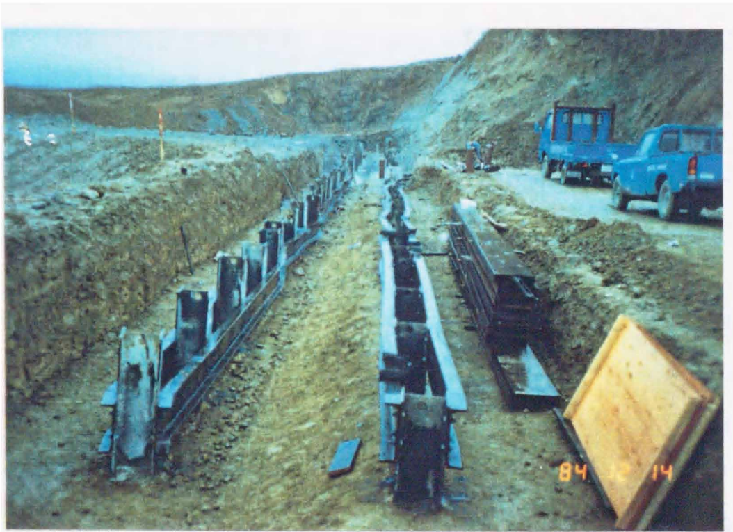
写真 4.7 B地区抑止杭の打設状況
