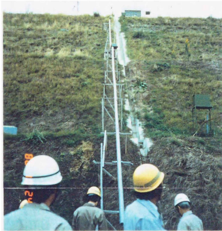
写真-5.1 西側斜面における地表伸縮計設置状況
