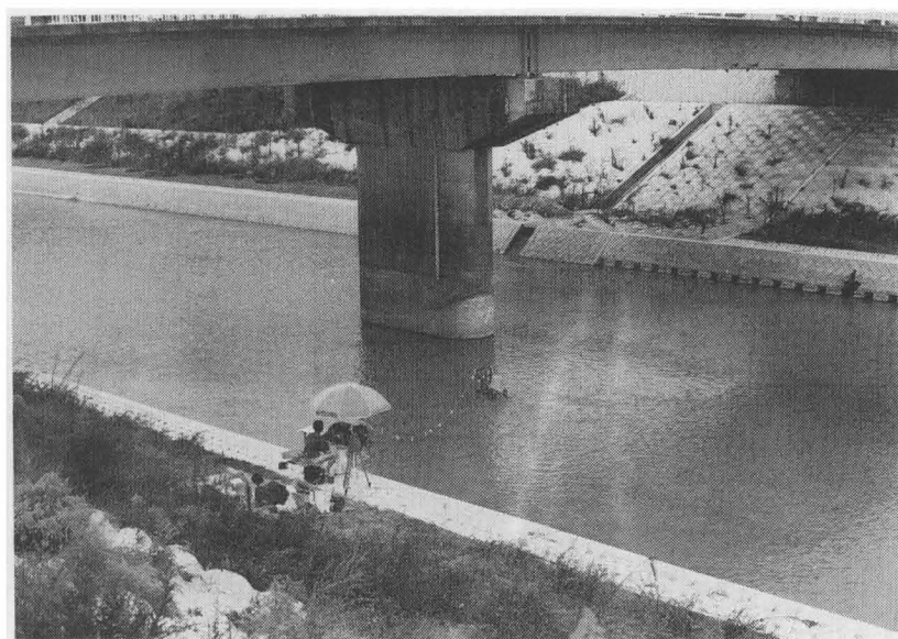
写真6-1 橋脚後流域の測定風景
