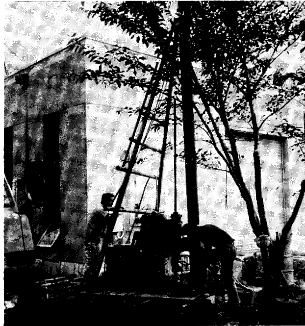
写真 3 - 1 サーマルウェル設置状況
