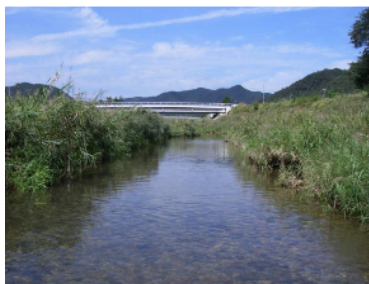
写真-2.3 河鹿橋付近(下流側から撮影)( )
