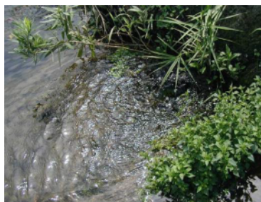
写真-2.6 護岸近傍の湧水(有明橋付近)( )
