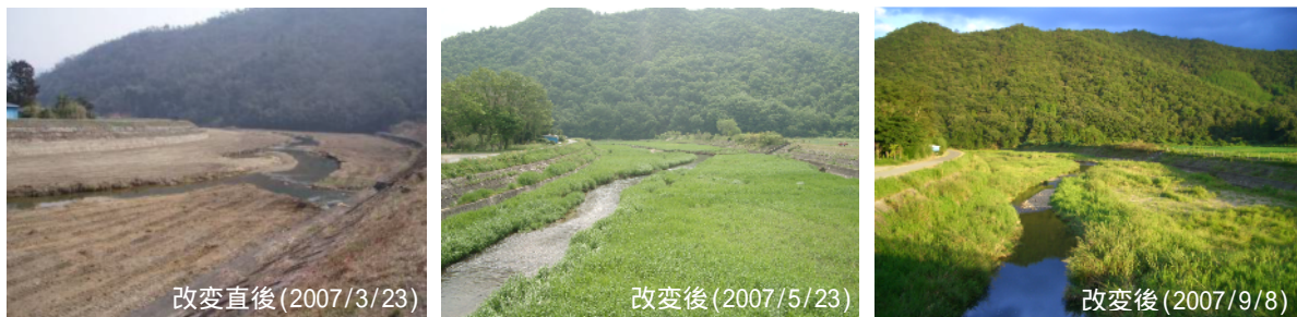
写真-5.5 砂州切り下げ, 変更直後(2007年3月)・変更後(2007年5月)・変更後(2007年9月)
