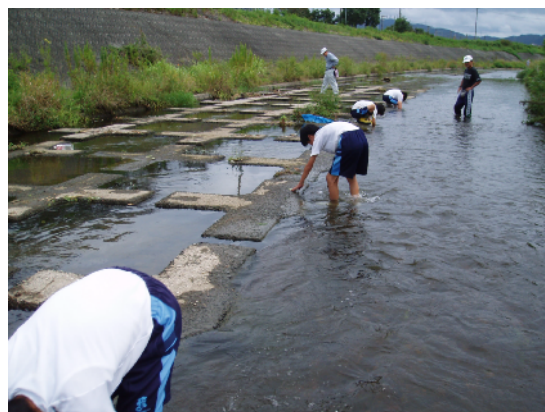
写真-2.8 現地の状況(実験箇所 b)
