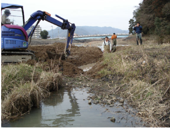
写真-7.5：小型の重機による掘削作業
