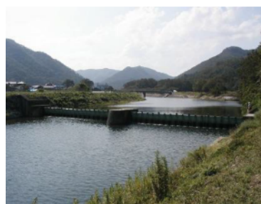
写真-2.2 麦尻井堰(下流から3基目)( )
