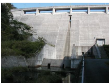
写真-2.1 安室ダム( )
