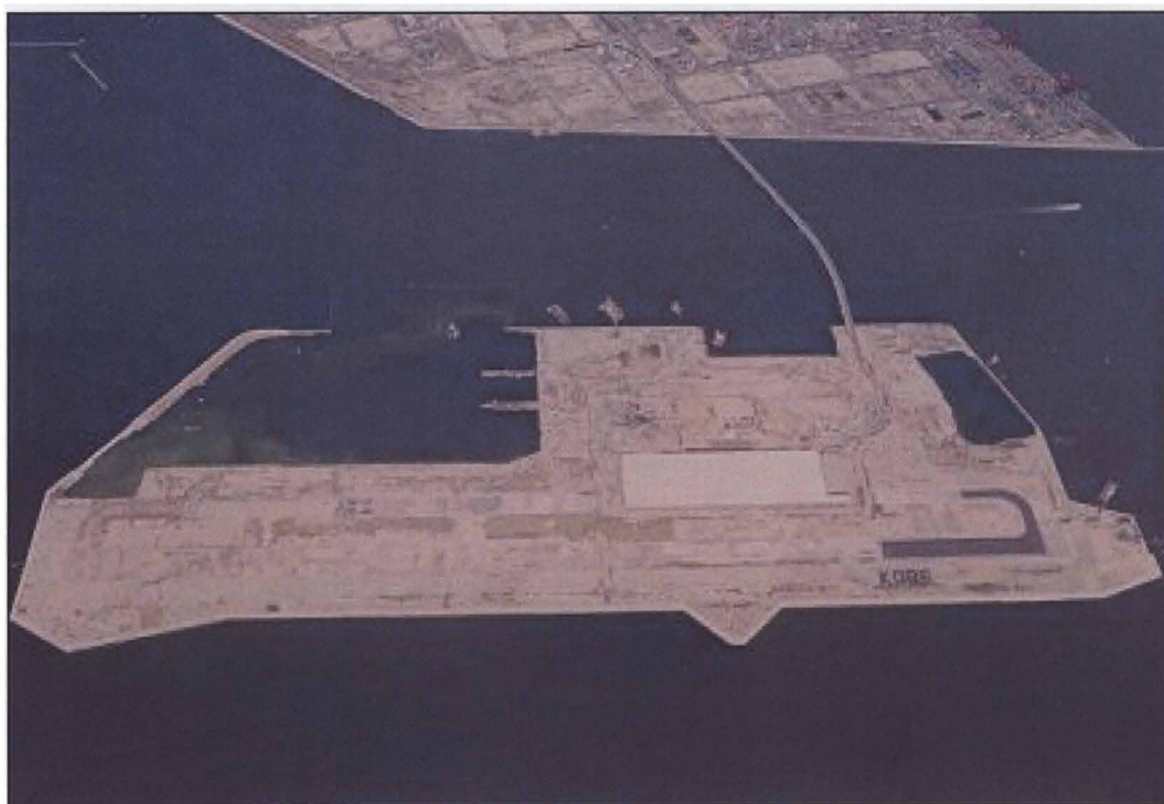
写真- 1.4 平成16年秋（空港施設内埋立造成完了間近）
