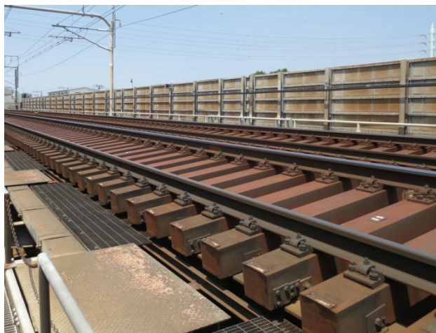
図5-1 無道床橋りょう
