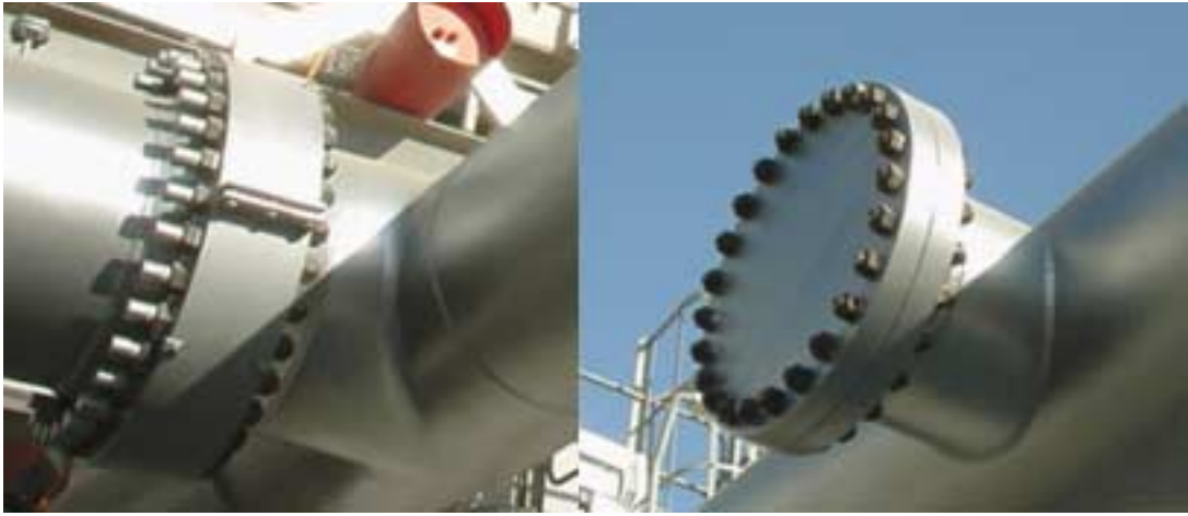
図 1.1 管フランジ締結体
