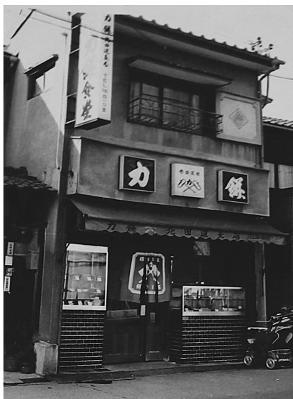
写真1 1960年頃の力餅食堂
