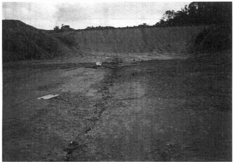
写真－5 A4 測線探查状況
