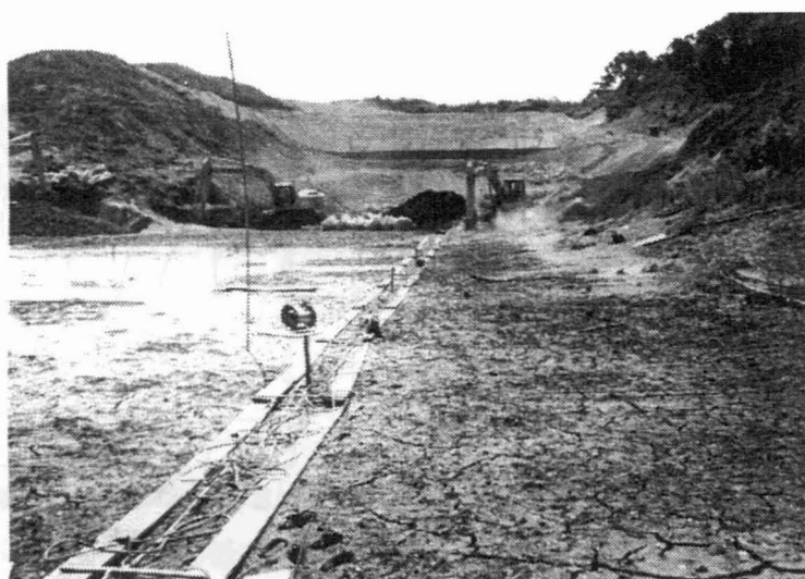
写真-1 A1 測線探索状況
