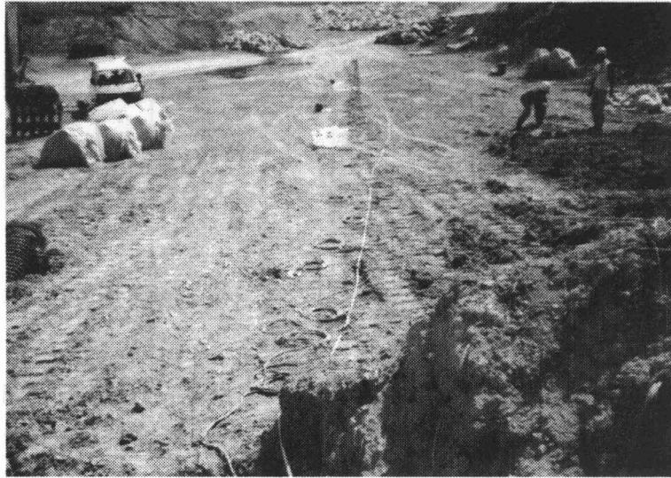
写真-2 A2測線探査状況
