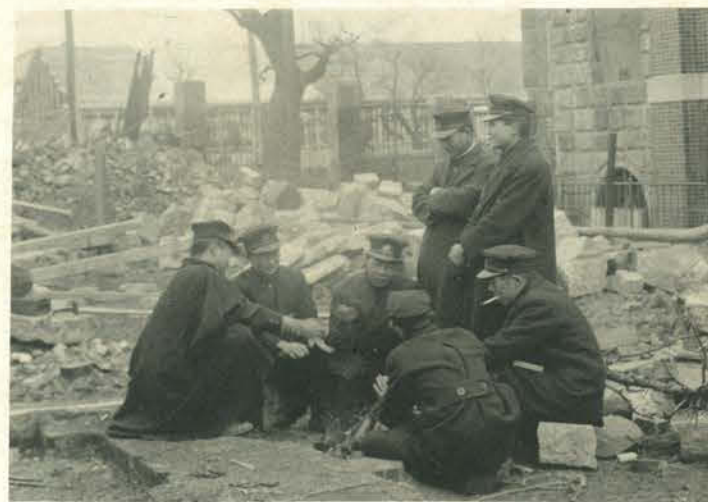
： 震災後の一橋 ：
